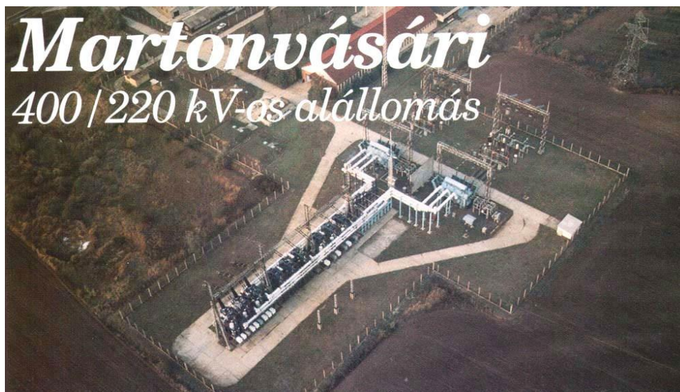
54. ábra A martonvásári 400/220 KV-os alállomás
